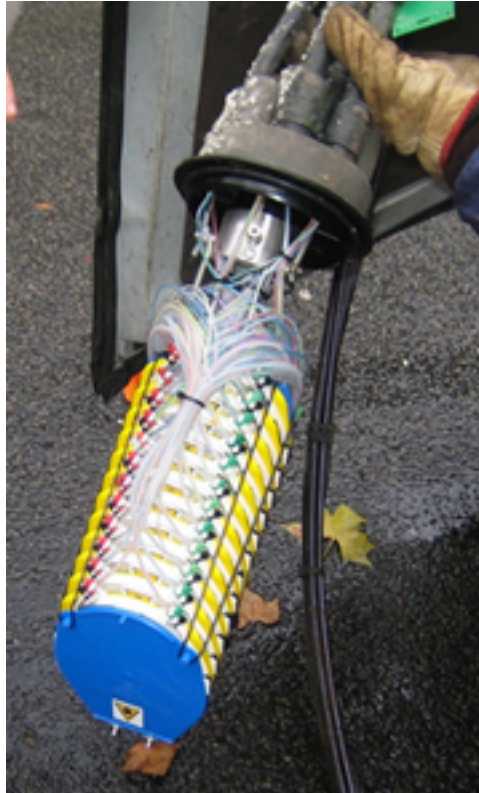
FIG. 3.4 – Boîte de jonction ouverte
